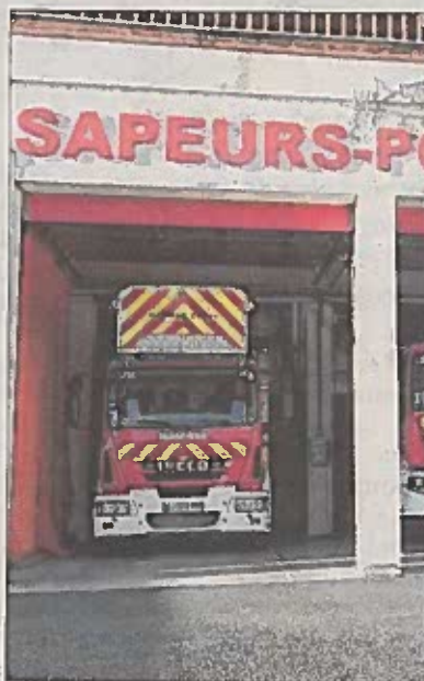
■ La caserne devrait déménager prochainement. Photo C. BEAUVENT
